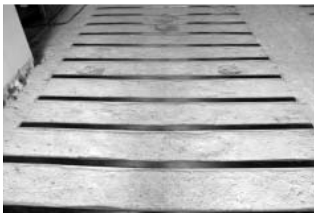
CFRPラミネート貼付け
