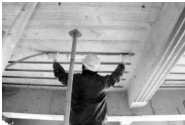
CFRPラミネート貼付け
