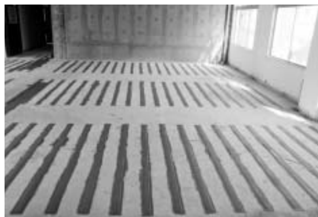
CFRPラミネート貼付け完了
