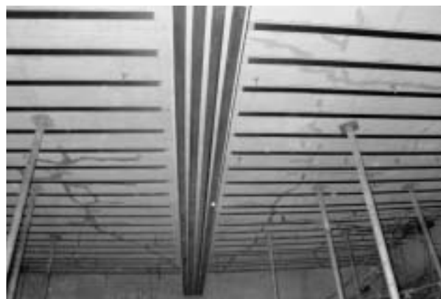
CFRPラミネート貼付け完了
