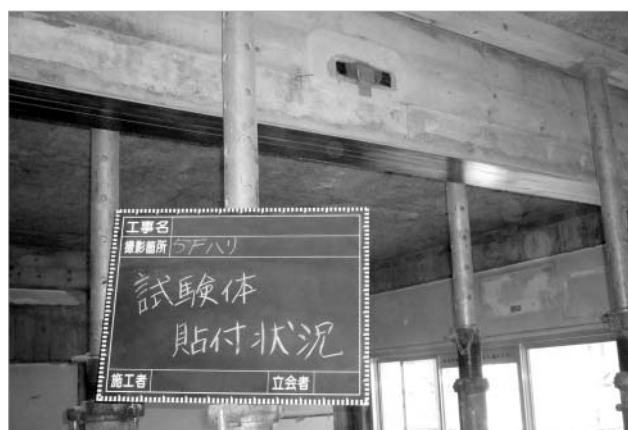
CFRPラミネート貼付け完了
