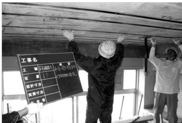
CFRPラミネート貼付け
