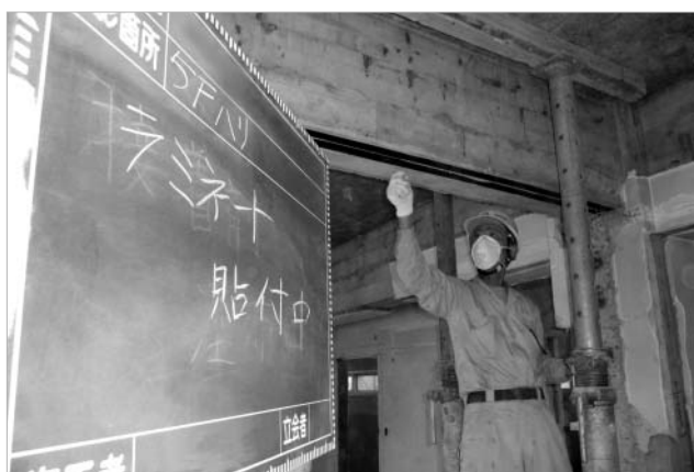
CFRPラミネート貼付け
