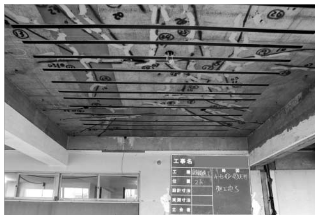
CFRPラミネート貼付け完了
