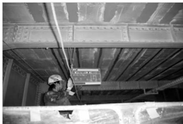
ラミネート貼付け完了
