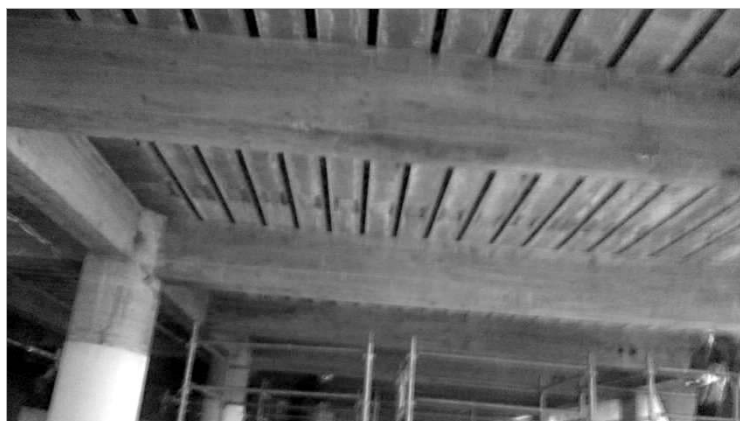
ラミネート貼付け完了
