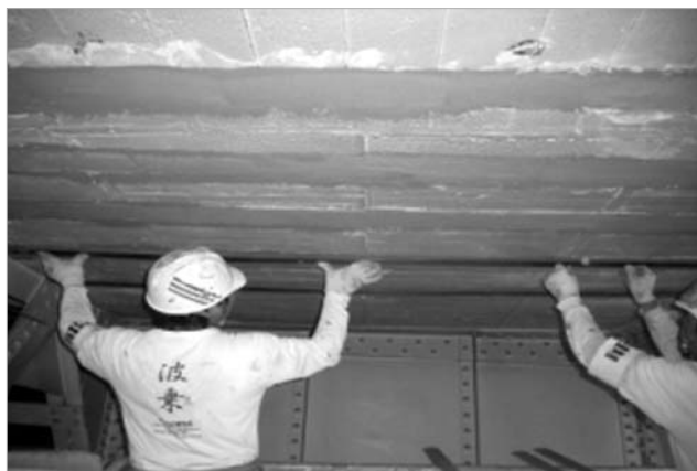
CFRPラミネート貼付け
