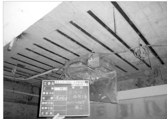
下面施工状況
