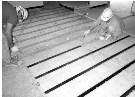
上面施工状況
