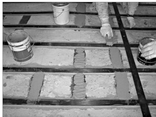
段差修正状況
