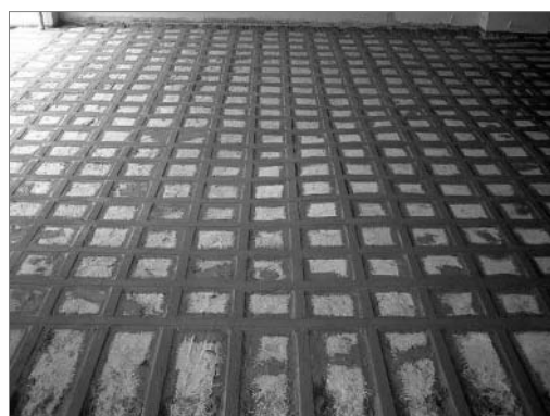
仕上げ用下地材塗布完了
