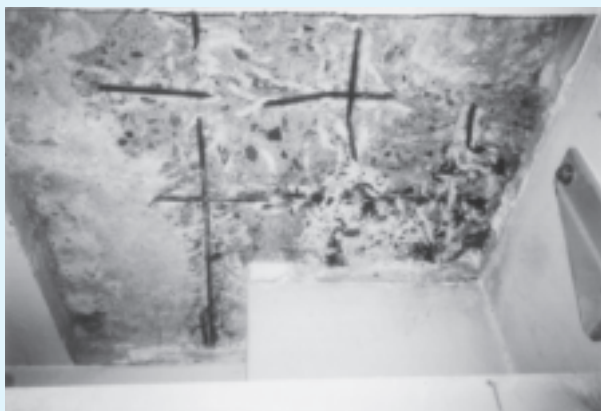
スラブ補強 施工前
