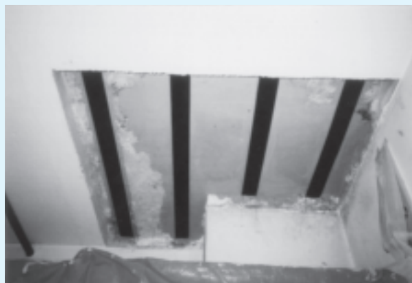
スラブ補強 施工後
