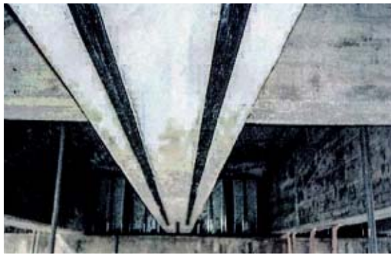
梁下面への貼付曲げ補強
