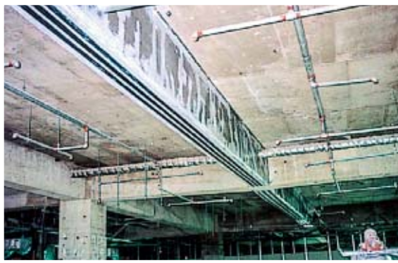
積載荷重の増加に伴う梁部材の曲げ補強
