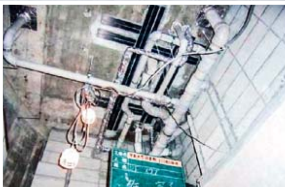
設備配管付近の設置開口部まわりの補強
