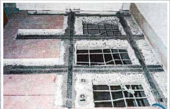
設置開口部まわりの補強
