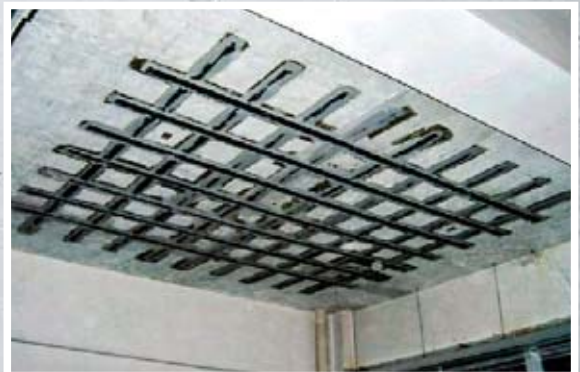
床スラブ下面中央部への貼付曲げ補強
