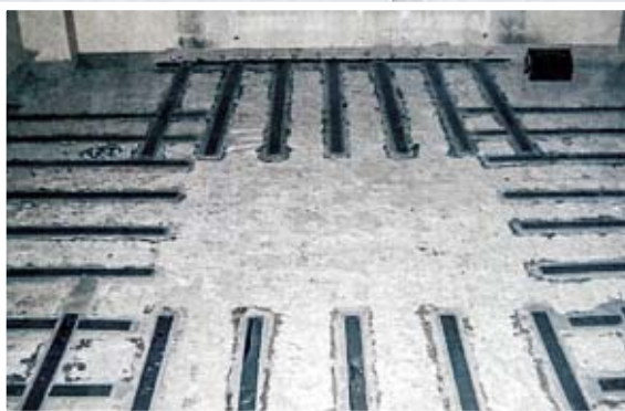
床スラブ上面周辺部への貼付曲げ補強
