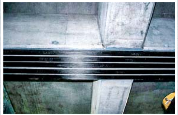
梁下面への全面的な貼付曲げ補強
