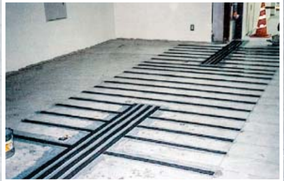
梁上面への貼付曲げ補強
