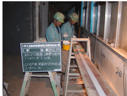
CFRP板貼り付け準備
