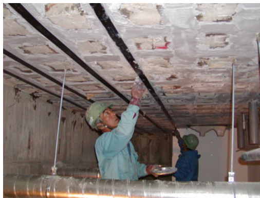
CFRP板貼付け状況
