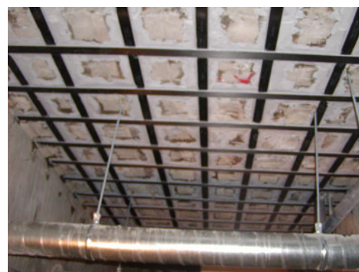
CFRP板貼付け完了
